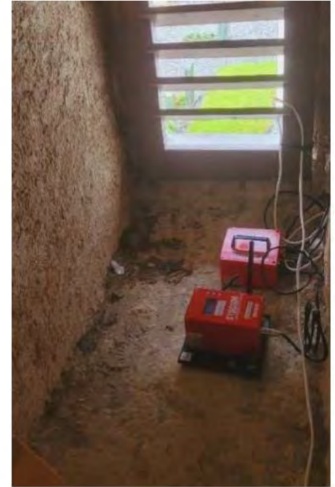
MP2 Kirchturm, 1. Obergeschoss
