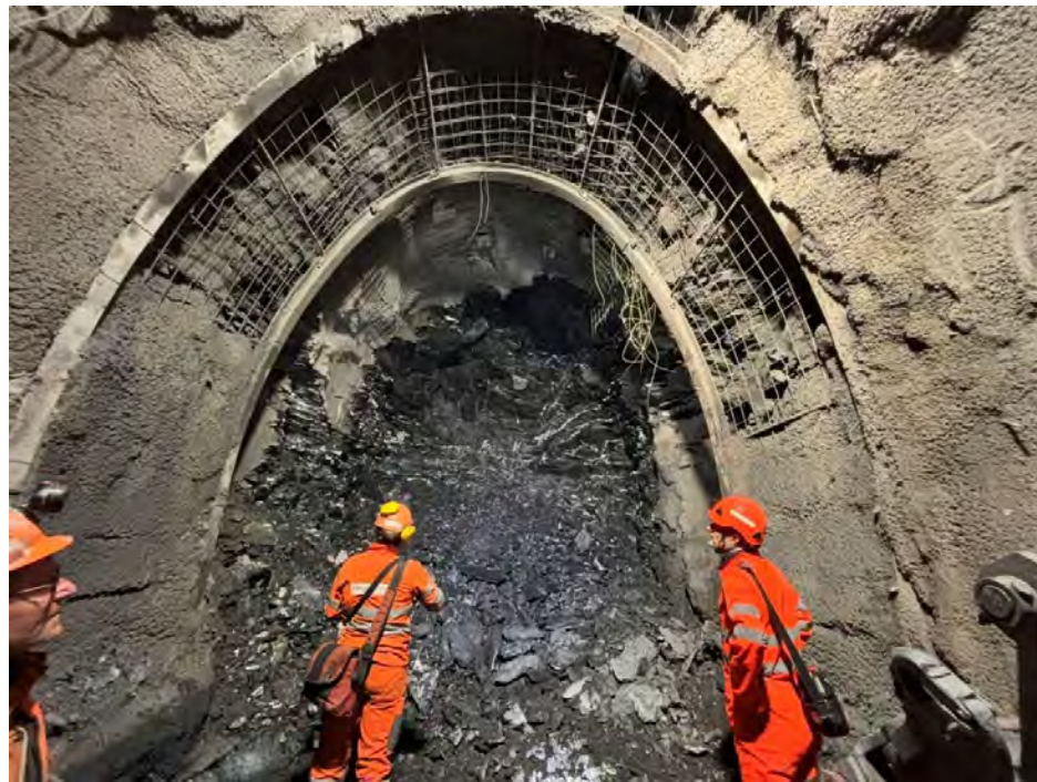
Einbau von Stahlträgern im Abstand von 1.50 m
