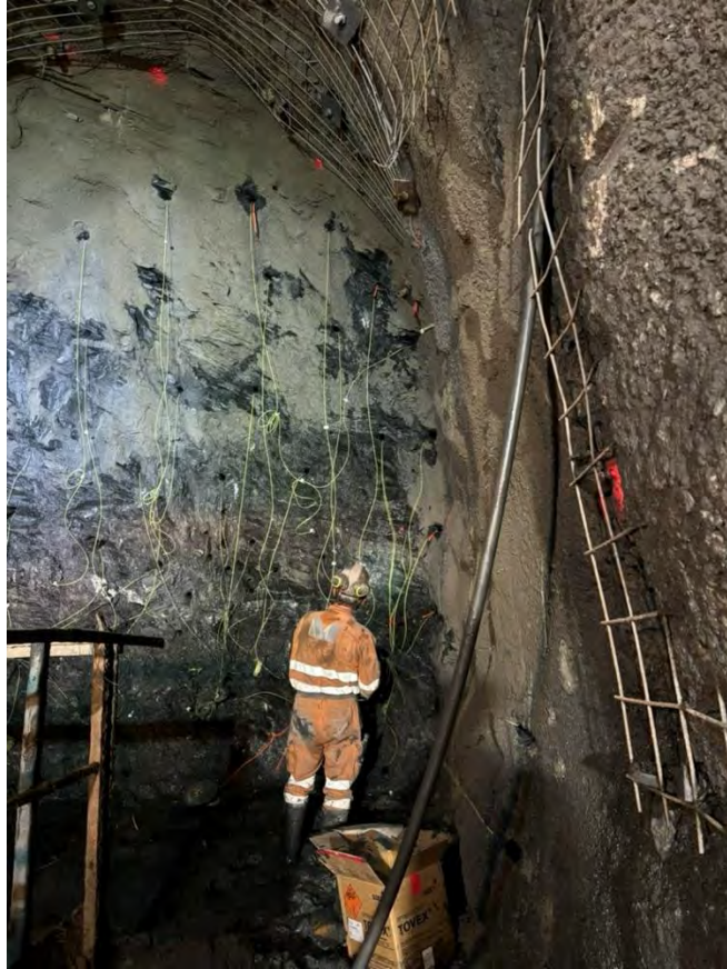
Bohren und Laden der Sprenglöcher für einen Abschlag (mit zweiarmigem Bohrjumbo)
