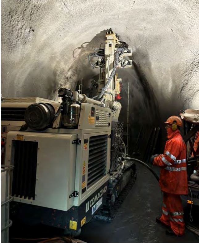
Drainagebohrung in die Rutschmasse DR4 (vertikal nach oben mit einer Länge von 100 m)
