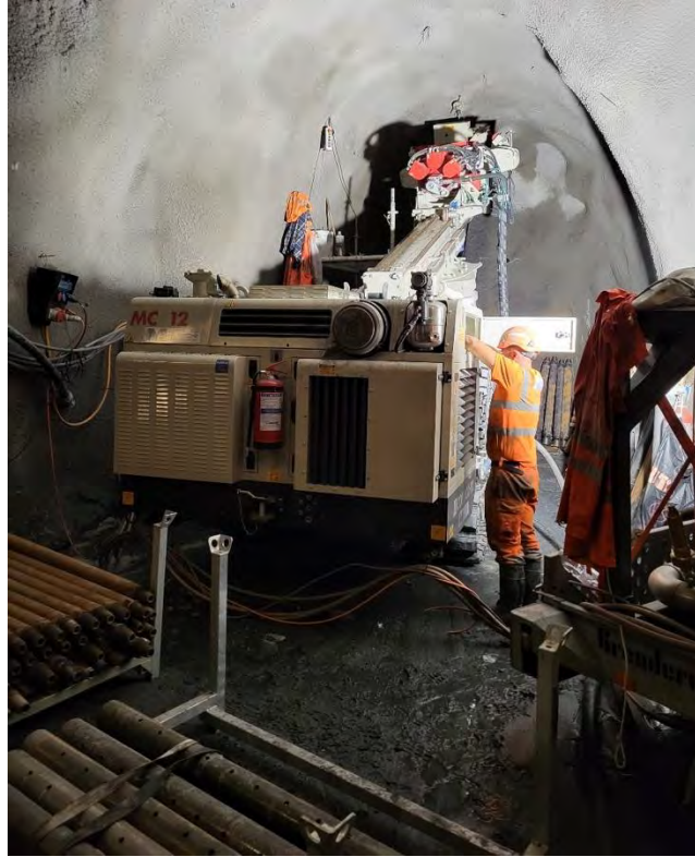
Drainagebohrung in den Fels DF5 (25% geneigte Bohrung mit einer Länge von 200 m)
