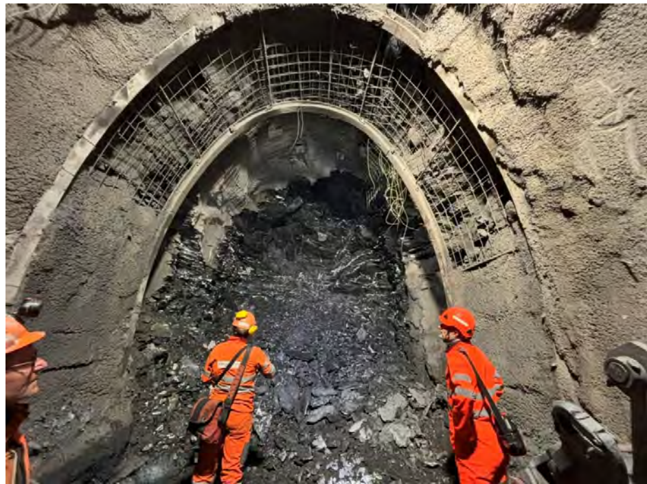
Einbau von Stahlträgern im Abstand von 1.50 m
