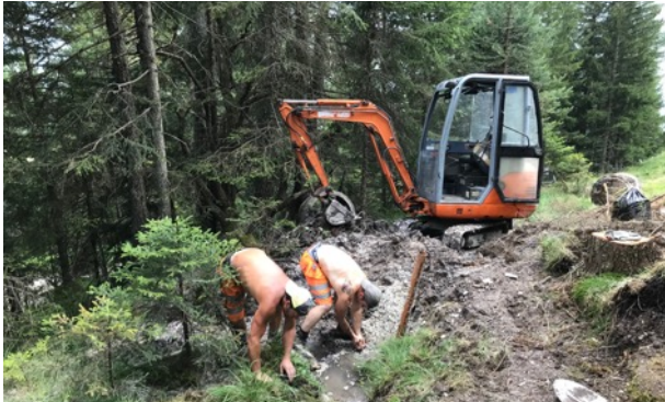
Handarbeit im unwegsamen Gelände: Zwei Arbeiter machen eine kleine Abflusssrinne frei.
