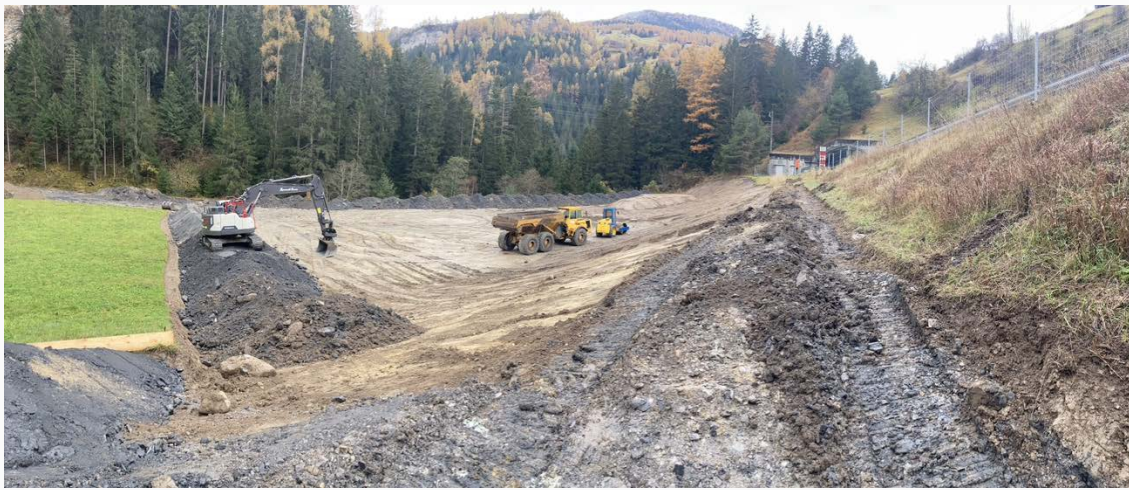
Vorbereitung der Deponie Tgampi. Bild: Tiefbauamt Graubünden, Ivan Degiacomi
