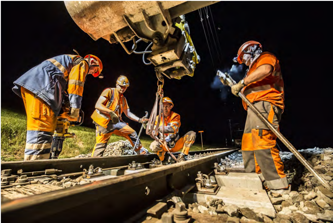
Reparaturarbeiten an Gleisanlagen in der Nacht.
