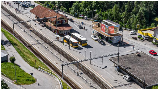
Blick auf Bahnhofareal Tiefencastel mit heutiger Postautostation
