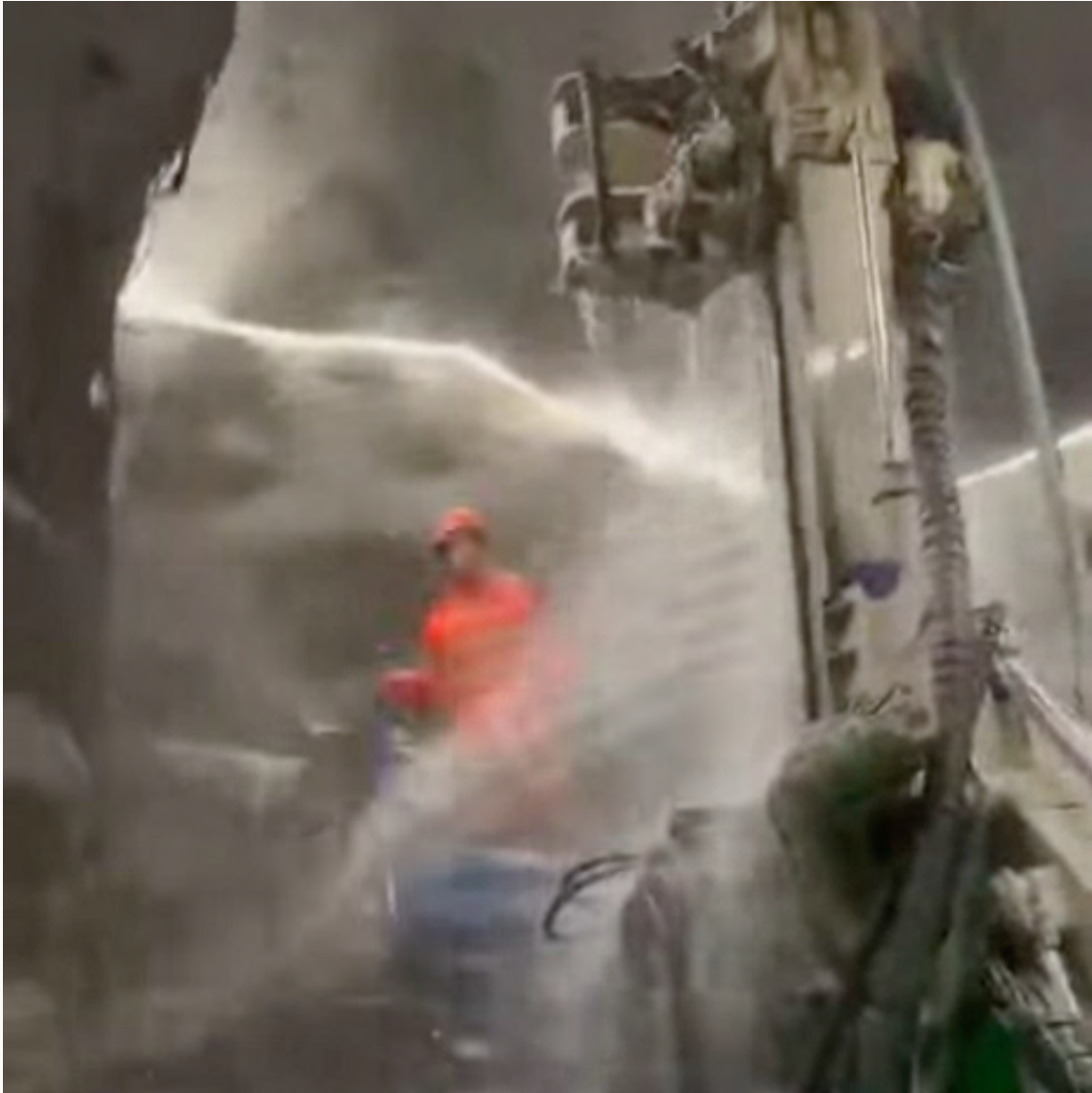
Anbohren des Wasservorkommens Armaus am 12. März 2026 (Video: Matteo Muttoni Costruzioni SA)
