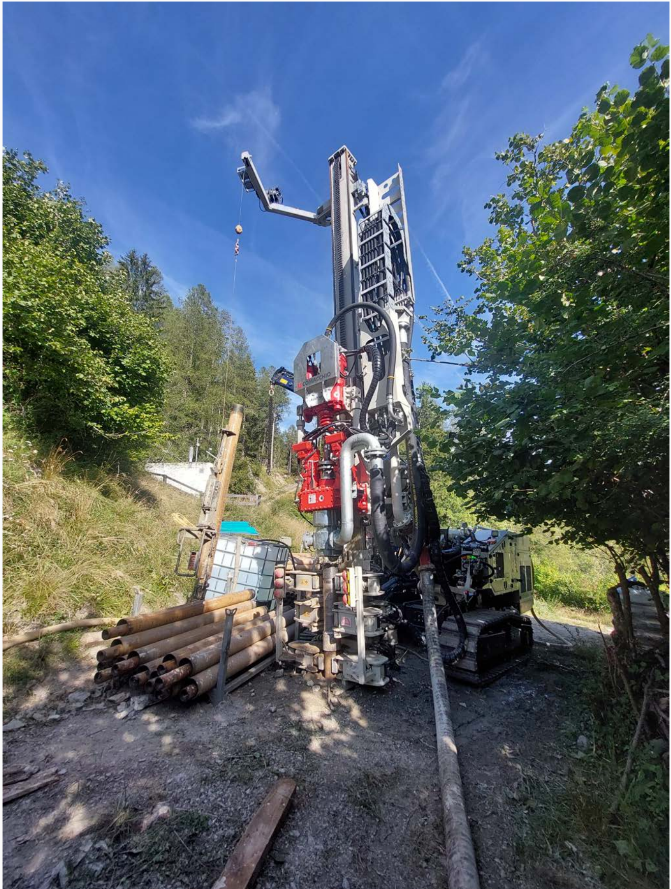
Bohrarbeiten an der Überwachungsbohrung «ÜB8» im September.
