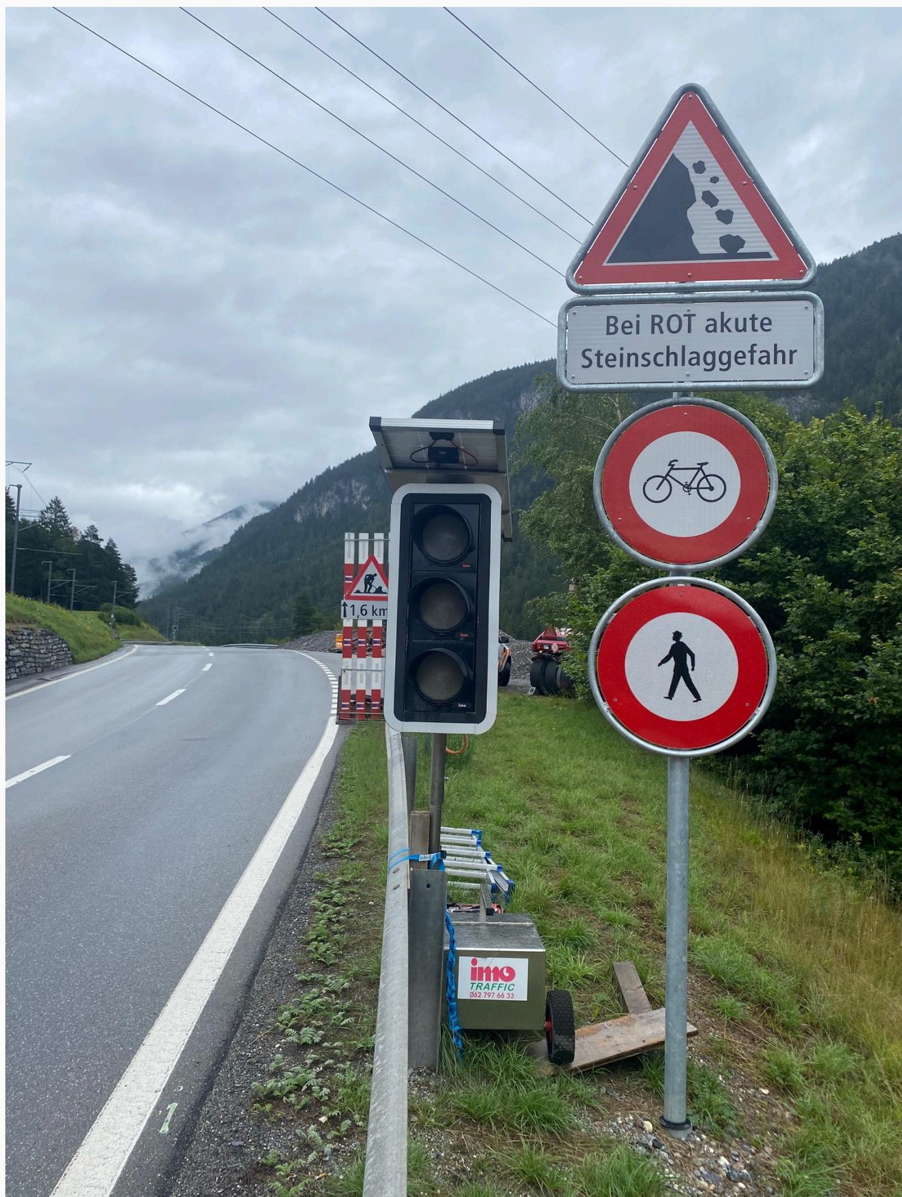
*Ampelanlage an der Kantonsstrasse zwischen Tiefencastel und Surava. Normalerweise sind diese Ampeln ausgeschaltet (schwarz). Bei Bedarf werden sie ferngesteuert eingeschaltet und schalten auf «ROT». Bild: Tiefbauamt Graubünden*
