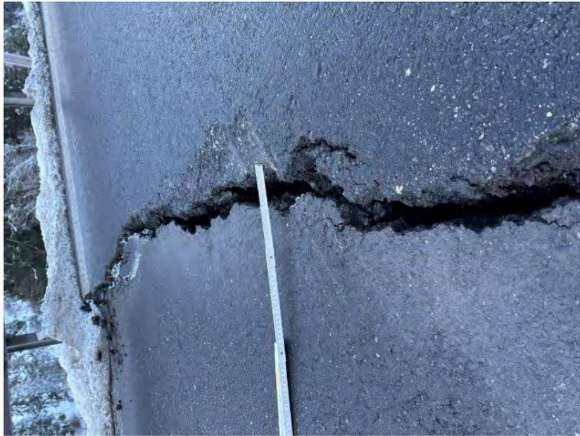
*Die Rutschung führt regelmässig zu schweren Schäden an den Strassenbelägen*
