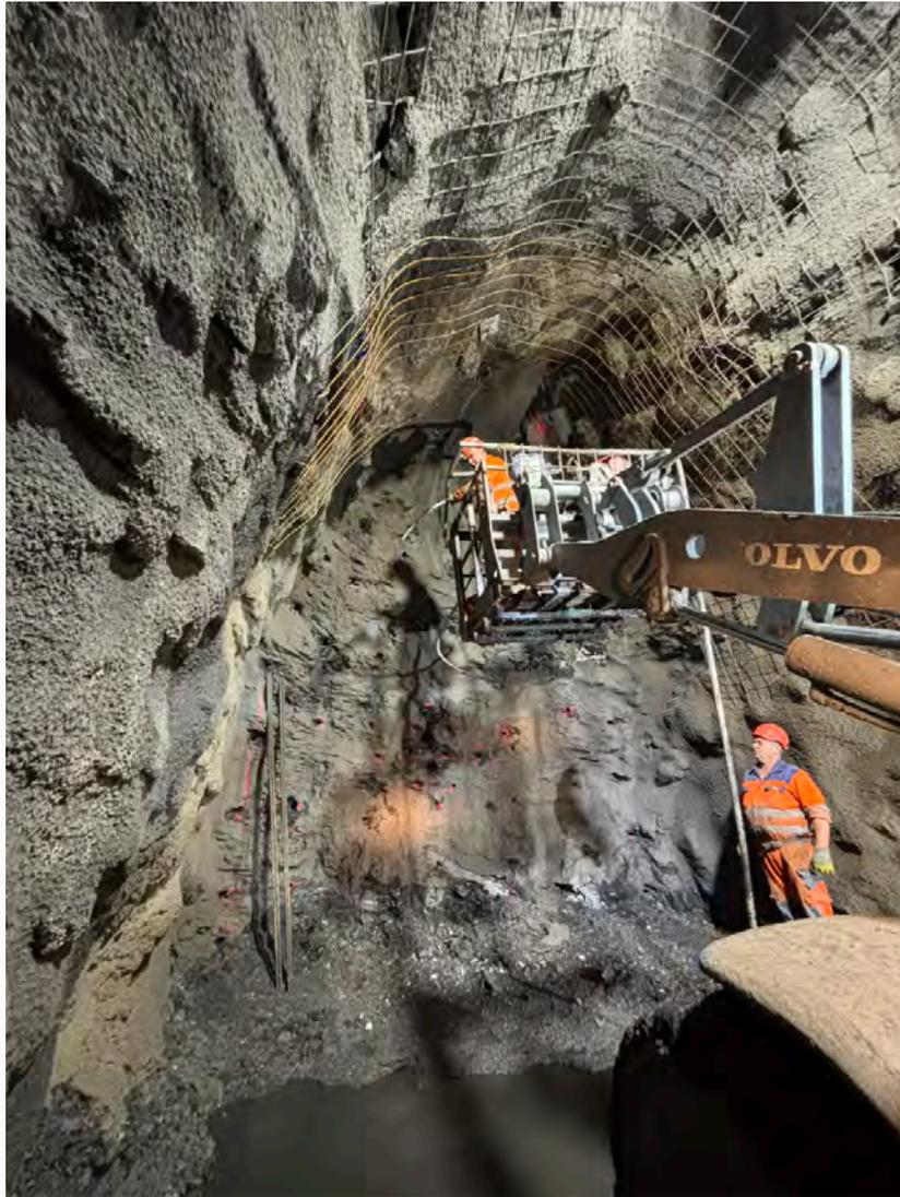
*Sicherungsarbeiten beim Bau des Entwässerungsstollens: Nach dem Ausbruch durch Sprengung wird die Stollendecke mit armiertem Spritzbeton gesichert.*
