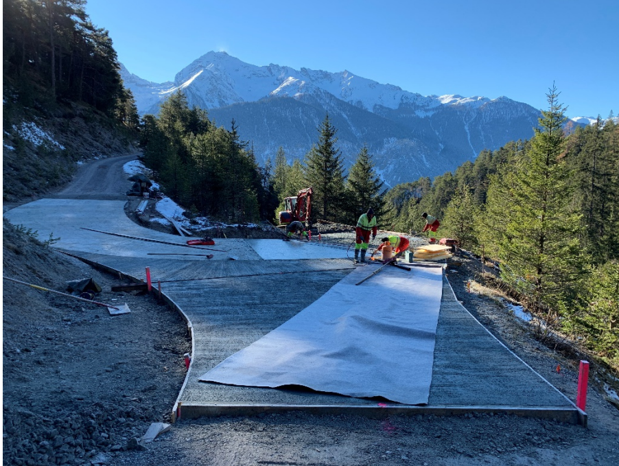
Wendeplatte Nr. 1 während den Betonarbeiten am 24. November (Foto: Carlo Guetg)
