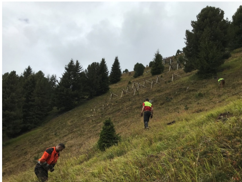
Auspflanzung der erstellten Schutzbauten im Anrissgebiet des Lawinenzugs von 1951 bei Pro Pigniel (Foto: Ben Turner)
