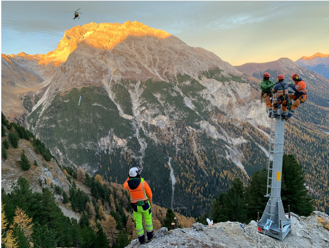
Montage Sprengmasten C1 am 29.10.2021 (Foto: Urs Fliri)
