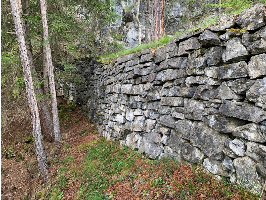
Steinschlagdamm SSV Greifenstein RhB (Foto: Urs Fliri)
