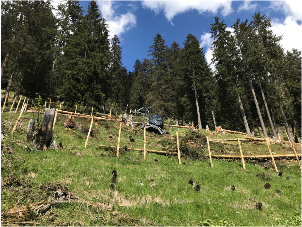
Bau Wildschutzzaun 92 in Bergün im God da Speschas (Foto: Ben Turner)
