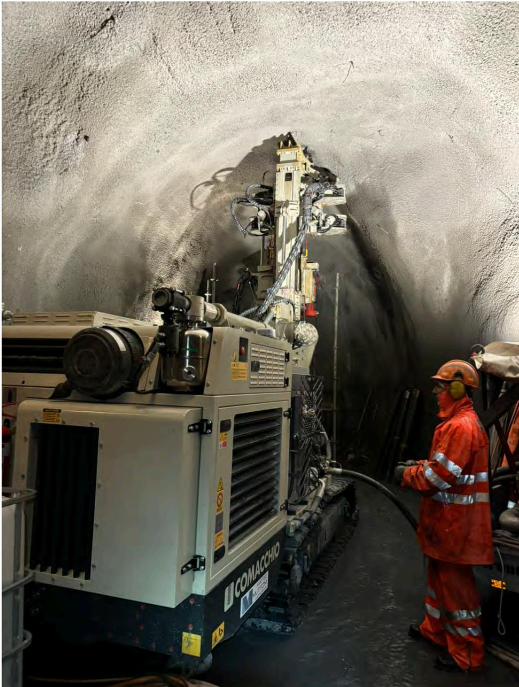
*Die erste Bohrung aus dem Entwässerungsstollen hinauf in die Rutschmasse wurde Anfang Oktober ausgeführt.*
