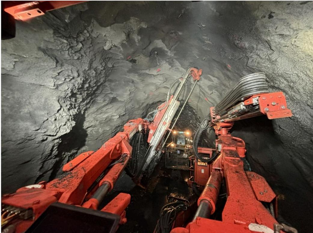
*Durch Bohren und Versetzen von Ankern wird das Stollengewölbe gesichert.*
