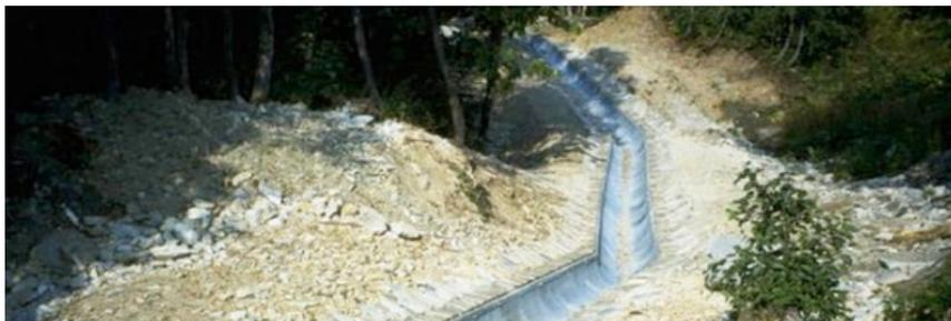
*Das neue Entwässerungssystem setzt wieder auf offene Gräben und Kanäle – ausgelegt mit Halbschalen aus gewelltem Stahlblech.*
