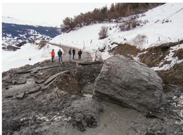
**Abb. 4: Beim Ereignis am 13. Dezember 2008 lösten sich in der Felswand oberhalb der Verbindungsstrasse Brienz – Lenz etwa 20 000 m<sup>3</sup> Gestein. Der Grossteil des abgestürzten Materials blieb am Fusse der Felswand liegen, einzelne sehr grosse Blöcke stürzten aber weiter und zerstörten die Verbindungsstrasse, die in der Folge für mehrere Wochen unterbrochen war.** (Bild: TBA GR).
