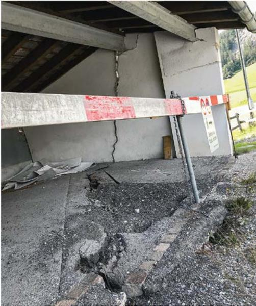
**Abb. 5:** Schäden an Gebäuden und Infrastrukturanlagen machen die Auswirkungen der Rutschung Dorf zunehmend sichtbar. (Bild: AWN)
