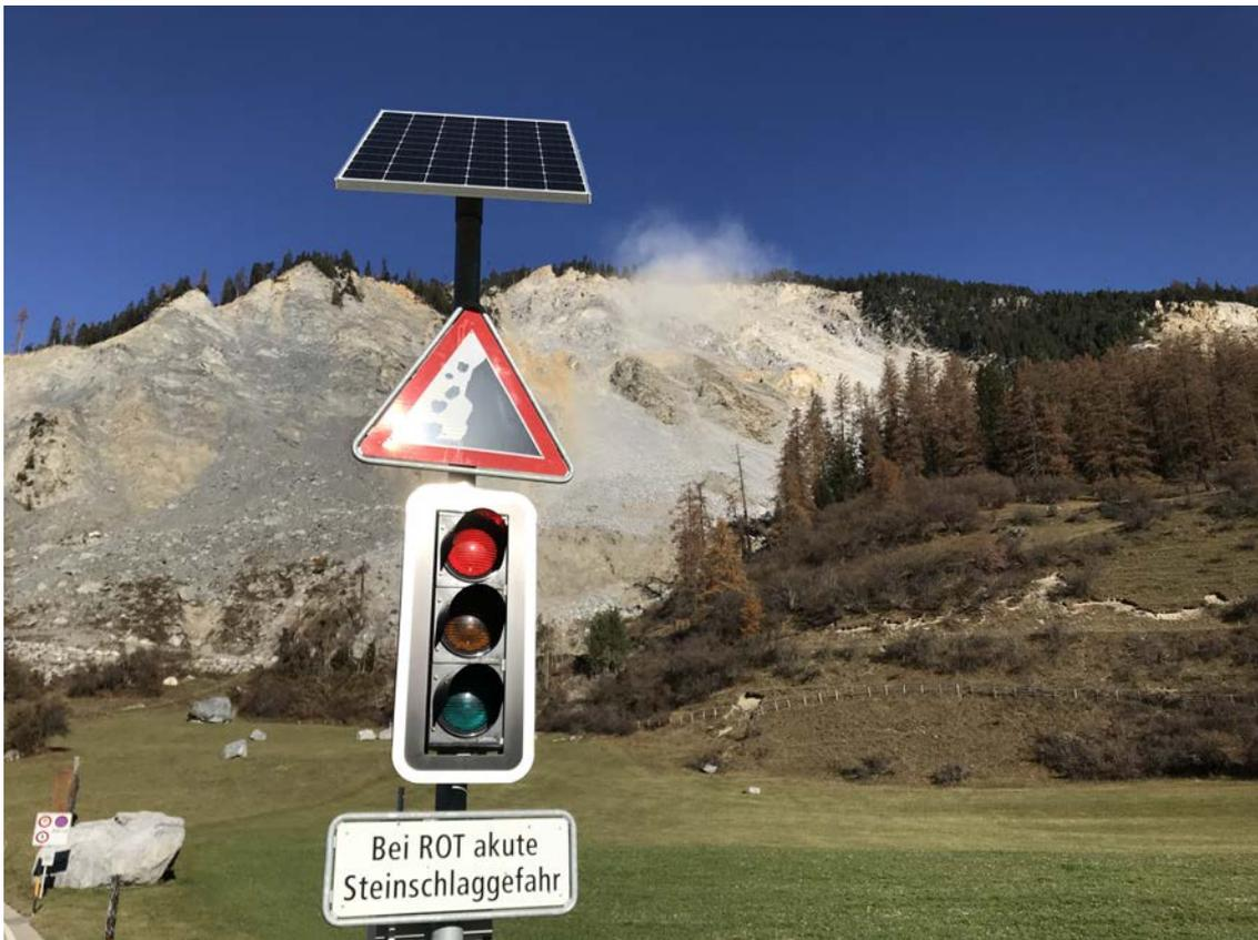
*Die Ampelanlage an der Briener Strasse nach Lantsch/Lenz: Ein Doppler-Radar am Schulhaus erkennt abstürzende Felsblöcke, analysiert die Gefährdung, die von ihnen ausgeht und sperrt bei Bedarf vollautomatisch die Strasse. (Bild: [gartmann.biz](http://gartmann.biz))*
