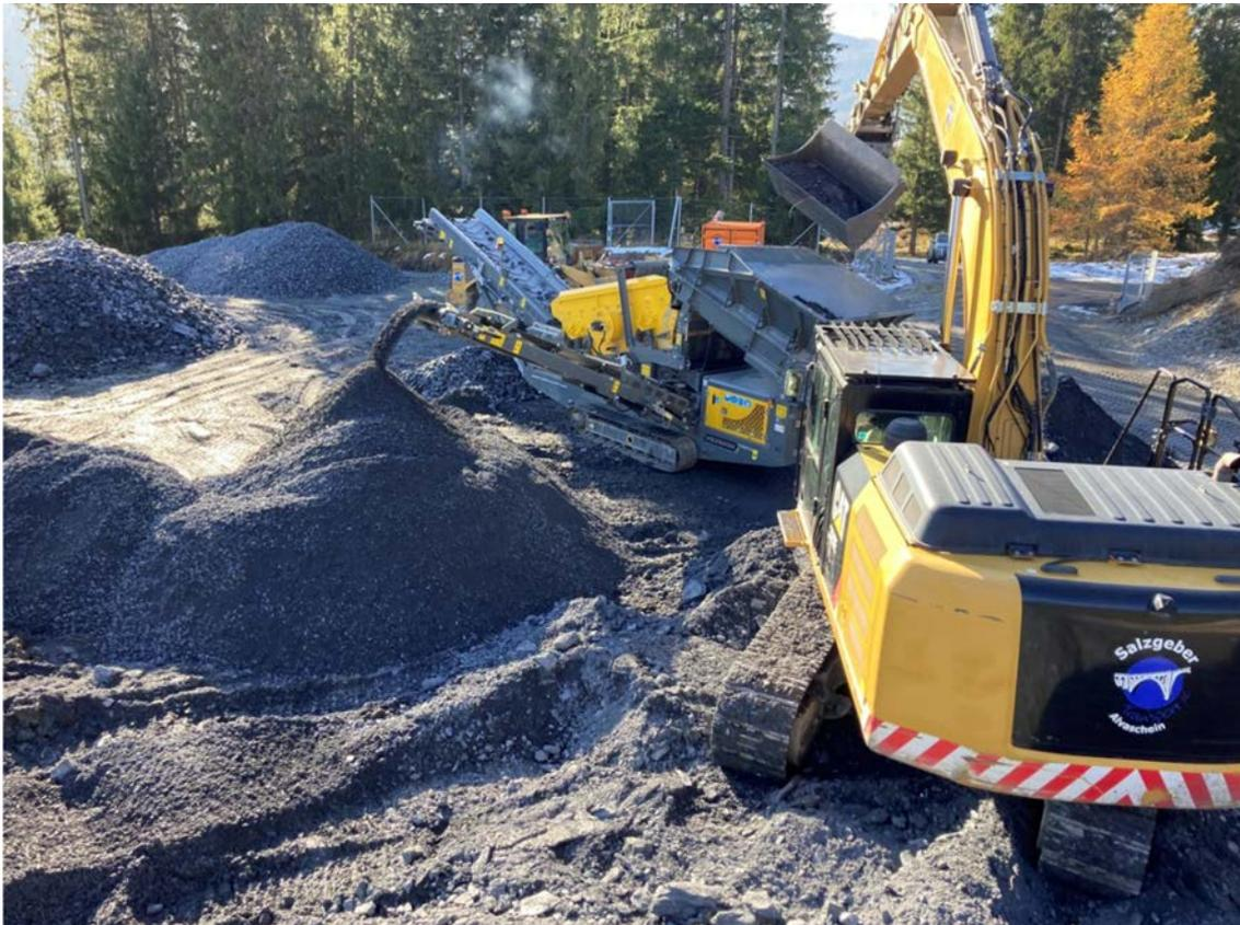
Rund 40 Prozent des Ausbruchsmaterials aus dem Stollen kann aufbereitet und auf dem Bau wiederverwendet werden. Das ist weniger als erwartet: Vor Baubeginn war mit etwa 70% Wiederverwertbarkeit gerechnet worden.
