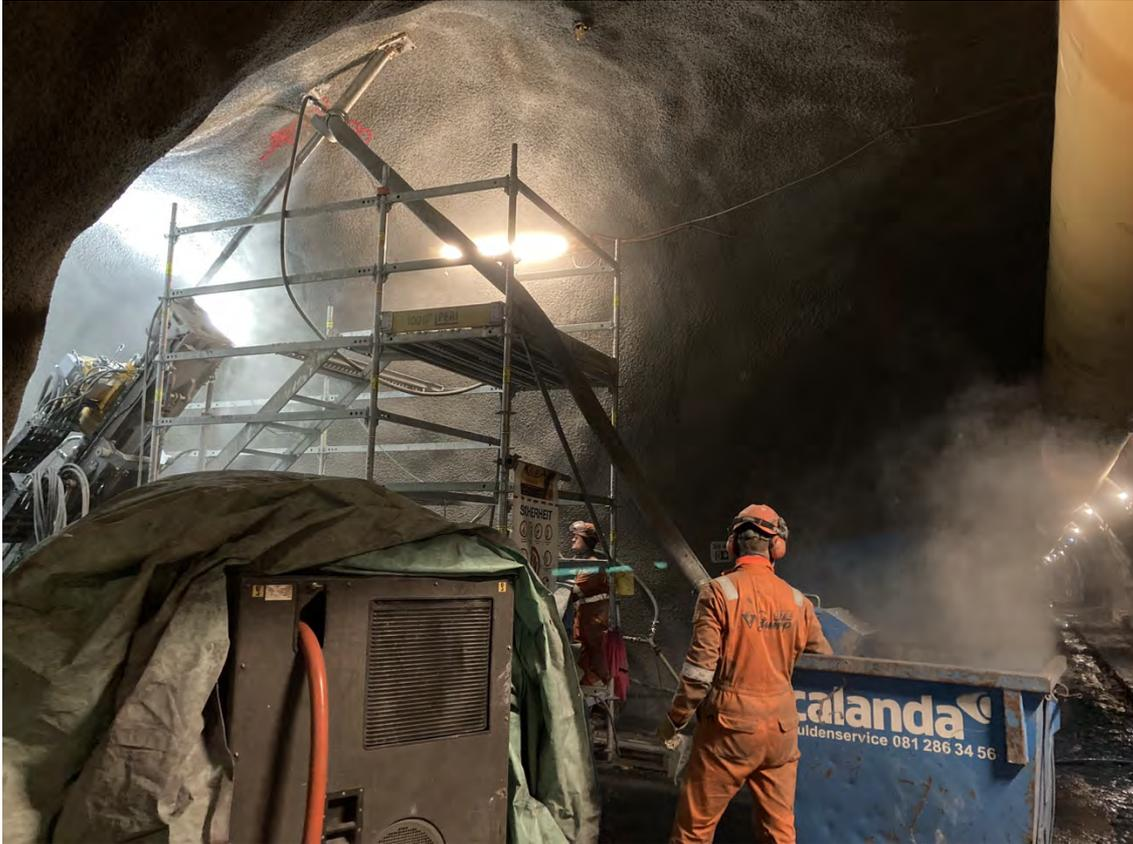
*Die erste Entwässerungsbohrung aus dem Stollen führt aus der Nische 2 in den über dem Stollen liegenden Fels.*
