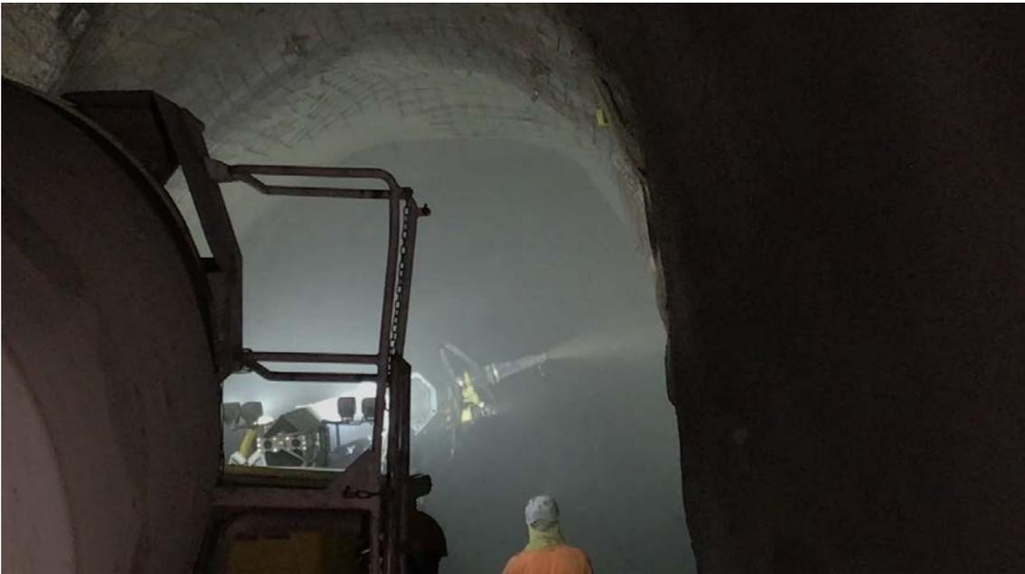
*Das Stollengewölbe wird mit Ankern, Eisenmatten und Spritzbeton verkleidet und gesichert.*
