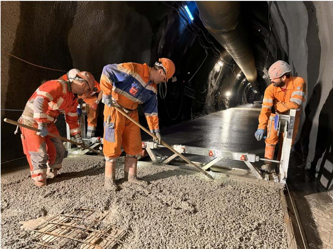
*Einbau der Betonsohle im Sondierstollen. Darunter liegt die zentrale Entwässerungsableitung, die das im Stollen gesammelte Wasser zum Portal ableitet. Bild: Andy Kiser, Frutiger AG*
