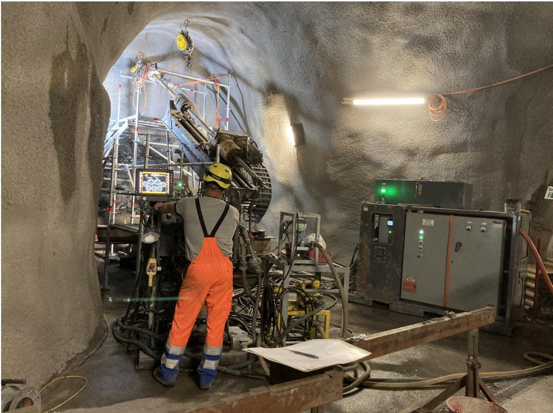
*Aus den Bohrnischen im Sondierstollen wurden im Juli noch einmal mehrere Entwässerungsbohrungen in den festen Fels getrieben.*
