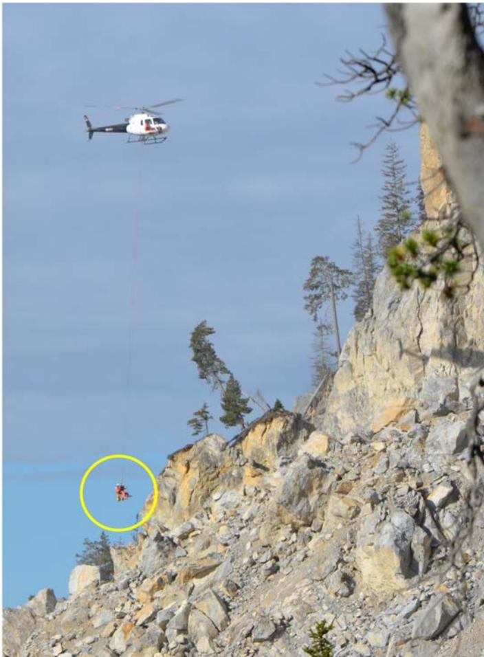
*Zwei Spezialisten werden vom Helikopter in die Insel der Rutschung Berg abgelassen. Dabei bleiben sie immer am Seil. Der Helikopter schwebt über ihnen und kann sie sofort aus der Rutschung evakuieren, falls ein Steinschlag abgeht.*
