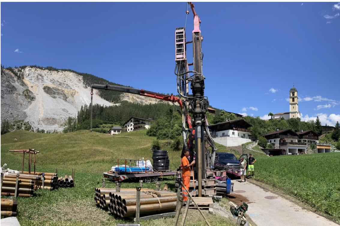
*Eine Überwachungsbohrung unterhalb des Dorfes wird erstellt.*
