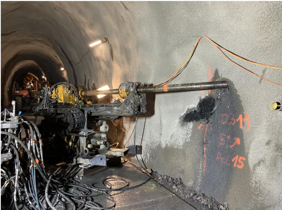
*Die Entwässerungsbohrung 11 führt aus dem Sondierstollen 150 Meter tief in den festen Fels unter die Wiese westlich des Dorfes. Sie wurde im November erstellt.*
