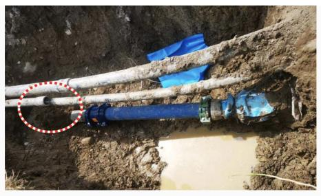
Leitungsreparatur an einer Wasserleitung (blaues Rohr). Im Kreis das auseinandergezogene Kabelschutzrohr einer Elektroleitung. Das Kabel darin ist intakt geblieben.
