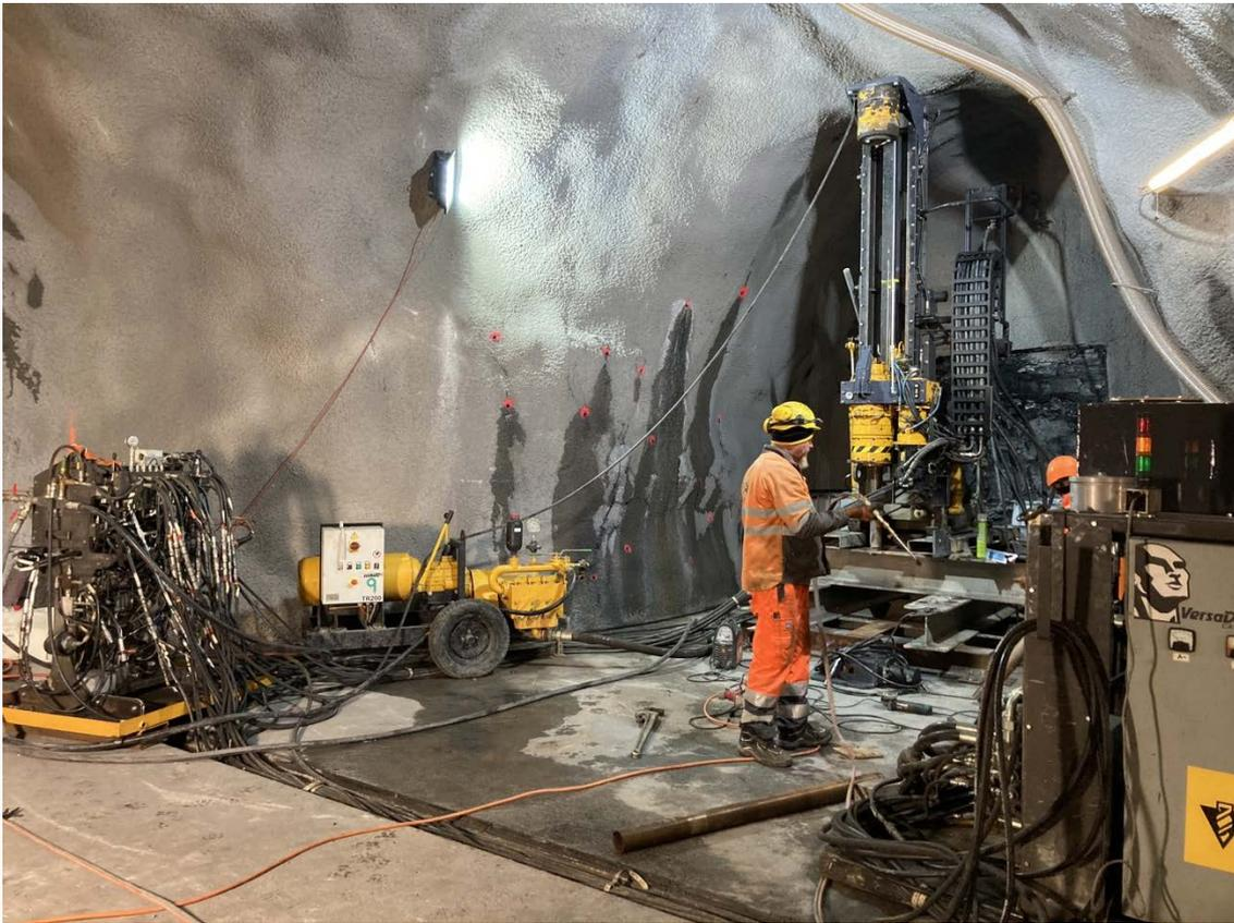
*Nach dem Ausbruch und der Auskleidung des Stollens mit Spritzbeton werden mehr als 100 Bohrungen für die Entwässerung des Gebirges und der darüber liegenden Rutschmasse sorgen.*
