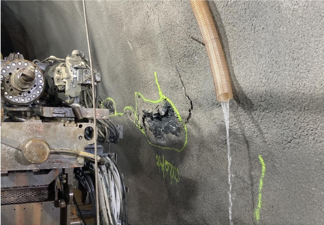
*Aus den Bohrungen nach oben in die Rutschmasse fliesst 10 bis 20 Mal mehr Wasser in den Stollen, als aus den Bohrungen in den umliegenden Fels unter der Rutschmasse.*
