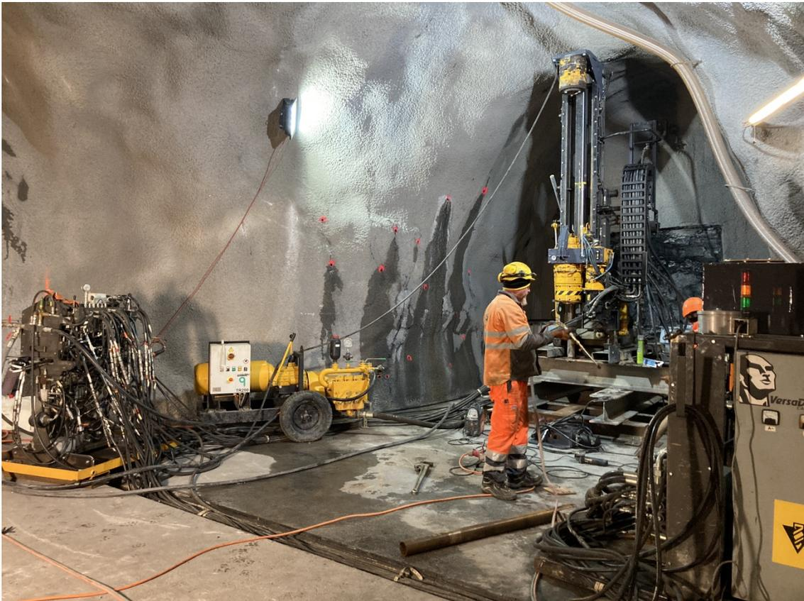
*Die erste Bohrung aus dem Sondierstollen in die Rutschmasse hat begonnen.*
