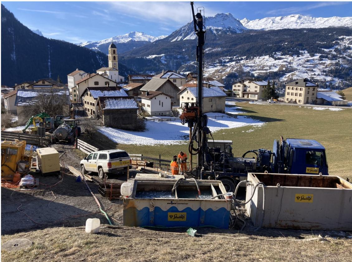
*Die Kernbohrung 14 wurde oberhalb des Dorfes erstellt und am 9. März abgeschlossen. In einem Pumpversuch wird nun bestimmt, wie gut Wasser in diesem Teil der Rutschmasse zirkulieren kann.*
