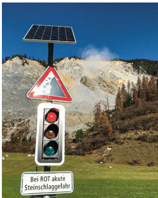
Die Kantonsstrasse nach Lantsch/Lenz wird bei Blockschlag automatisch gesperrt (Bild: Christian Gartmann)
