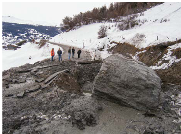
Abb. 4: Beim Ereignis am 13. Dezember 2008 lösten sich in der Felswand oberhalb der Verbindungsstrasse Brienz – Lenz etwa 20 000 m 3 Gestein. Der Grossteil des abgestürzten Materials blieb am Fusse der Felswand liegen, einzelne sehr grosse Blöcke stürzten aber weiter und zerstörten die Verbindungsstrasse, die in der Folge für mehrere Wochen unterbrochen war. (Bild: TBA GR).
