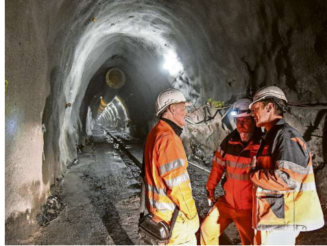
Gut vorangekommen: Baustellenchef Patrick Giovannini (oben) zeigt die aktuelle Ortsbrust im Sondierstollen. Das abgesprengte Material bringt ein Radlader nach draussen. Projektleiter Josef Kurath (unten links) erklärt im Baubüro die Vorgehensweise beim Stollenbau in Brienz/Brinzauls.
