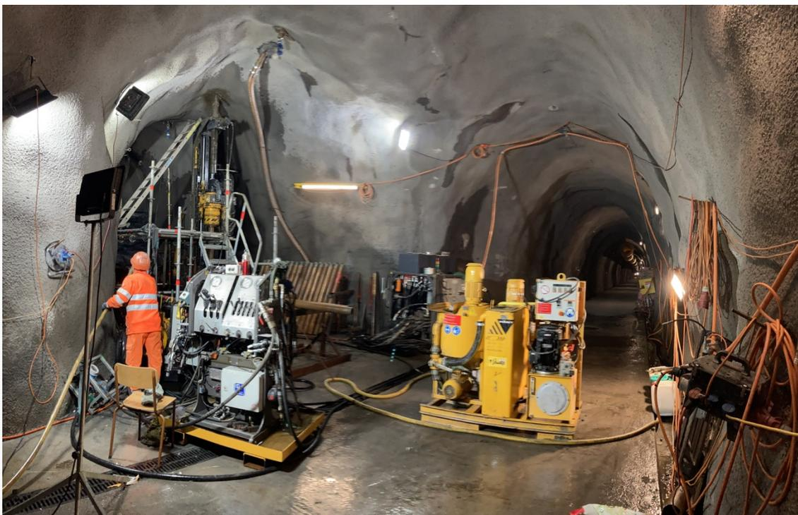
*Die Bohrarbeiten «über Kopf» aus dem Sondierstollen in die Gleitschicht und die rutschende Masse.*
